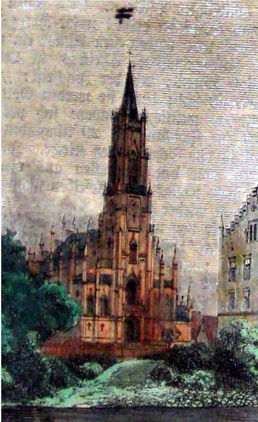
Die neue Matthäus-Kirche zu Bockwa bei Zwickau, 1853 bis 1856 errichtet.
